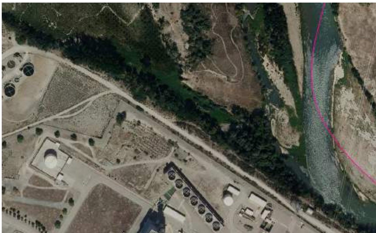
Ilustración 60. Vista aérea de la Interfaz urbana (industrial), forestal (arbolado) en Castejón.
